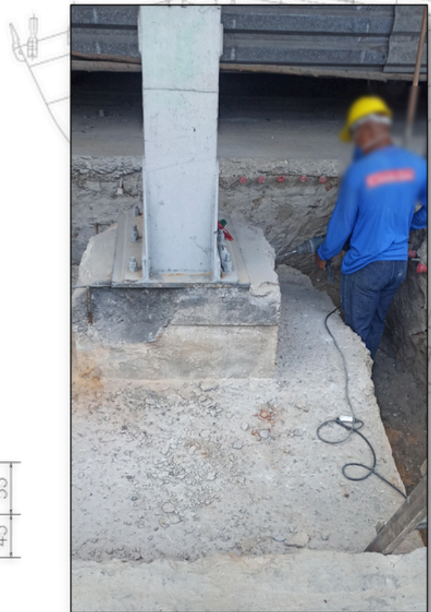
Implementação dos reforços em campo.
